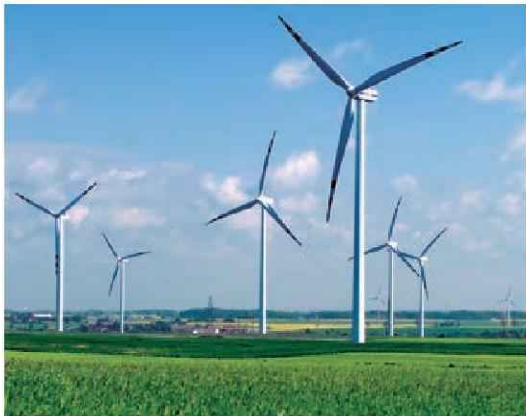
Pojedyncze turbiny w elektrowniach wiatrowych w Polsce mają zwykle moc 2–3 MW.
