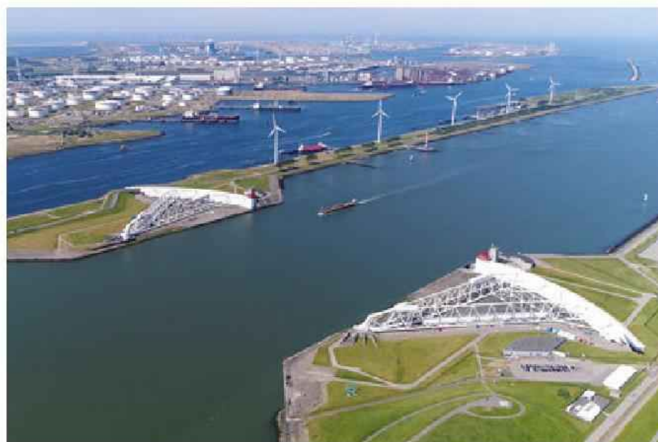
W Holandii buduje się ruchome zapory wodne, które chronią tereny przed powodzią i nie ograniczają żeglugi. Jedną z nich – Maeslantkering [wym. maslantkering] – znajduje się koło Rotterdamu.
