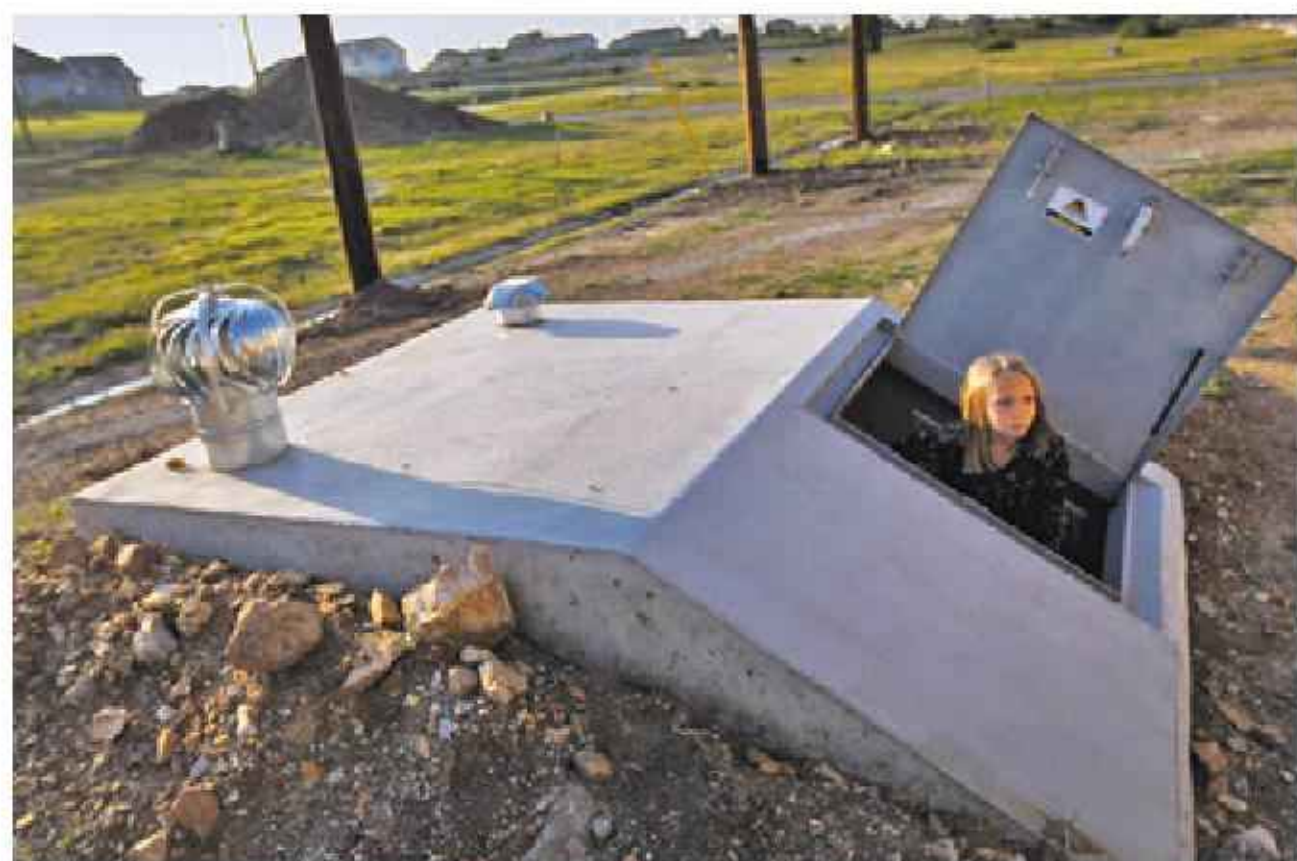
W Stanach Zjednoczonych, zwłaszcza w Alei Tornad, można przeczekać przejście trąby powietrznej w specjalnych schronach. Znajdują się one na przykład w mieście Joplin w stanie Missouri.
