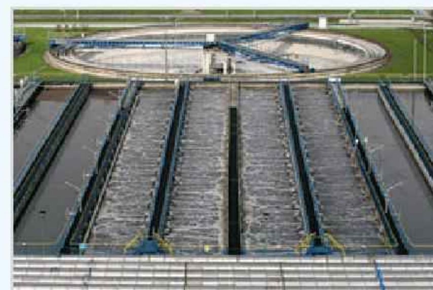
2 Nowoczesna oczyszczalnia ścieków w Lublinie.
