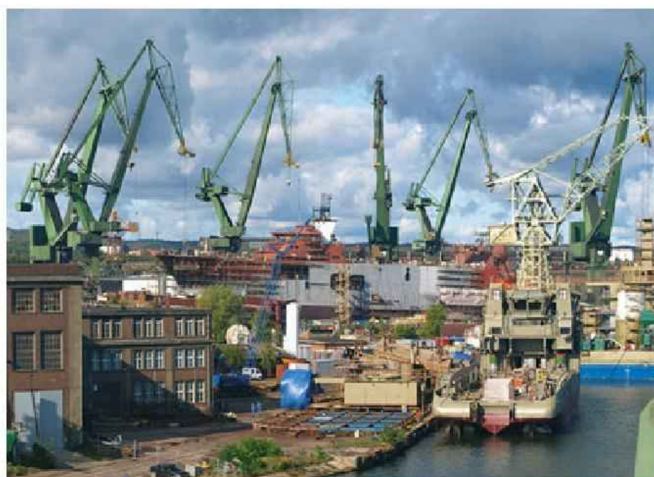
Wśród krajobrazów kulturowych wyróżnia się krajobrazy wodogospodarcze, portowo-stoczniowe. Występują one tam, gdzie znajduje się infrastruktura niezbędna do budowy i naprawy statków, np. w Stoczni Gdańskiej.
