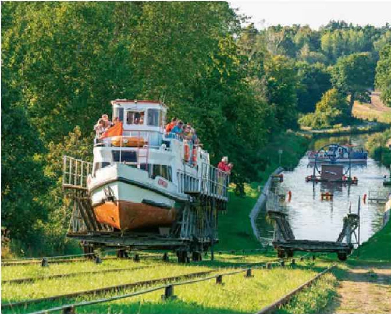
Kanał Elbląski to pomnik myśli technicznej. Część trasy statki pokonują drogą lądową po specjalnych pochylniach.
