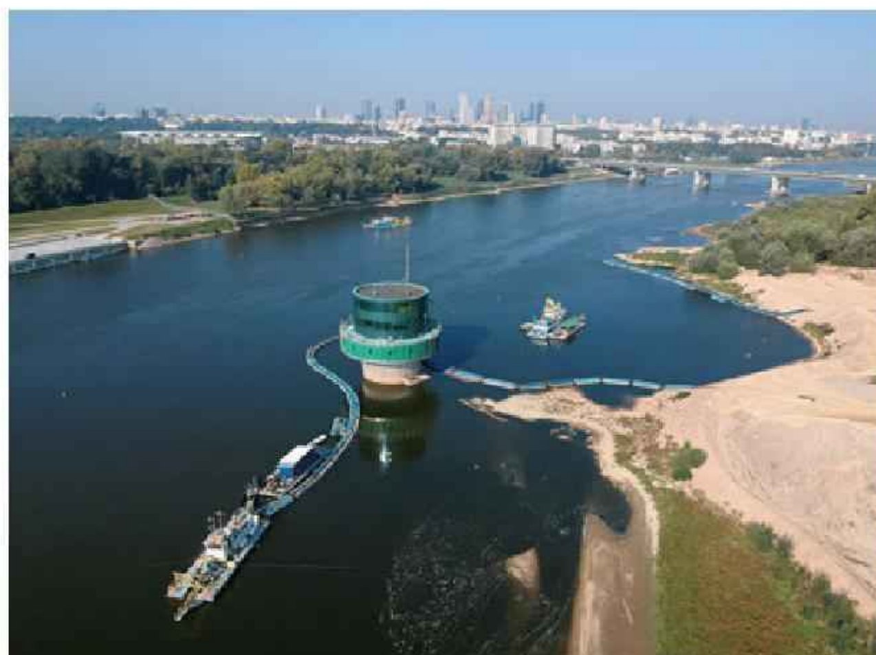
Zasoby wodne, do których człowiek ma stosunkowo łatwy dostęp, stanowią mniej niż 1% zasobów wody na świecie. Na fotografii ujęcie wody w Warszawie.
