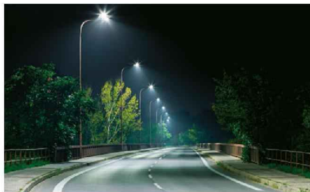
Zastosowanie diod LED w oświetleniu ulicznym umożliwia zaoszczędzenie nawet 70% energii w porównaniu z tradycyjnymi żarówkami.
