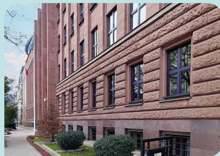
Fasada budynku Ministerstwa Spraw Zagranicznych w Warszawie.
