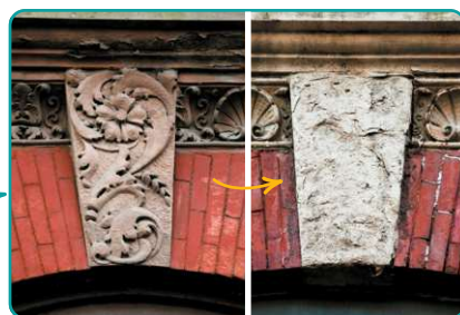
Niszczenie budynków i konstrukcji stalowych
