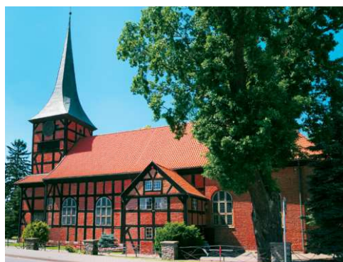
▲ Kościół w Steganie na Pomorzu – przykład tradycyjnego budownictwa w tym regionie.
