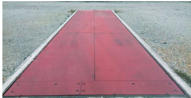
Waga wmontowana w jezdnię
