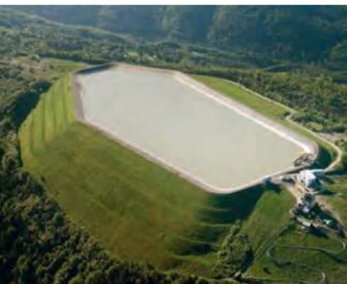
Zbiornik górny elektrowni szczytowo-pompowej Porąbka-Żar.
