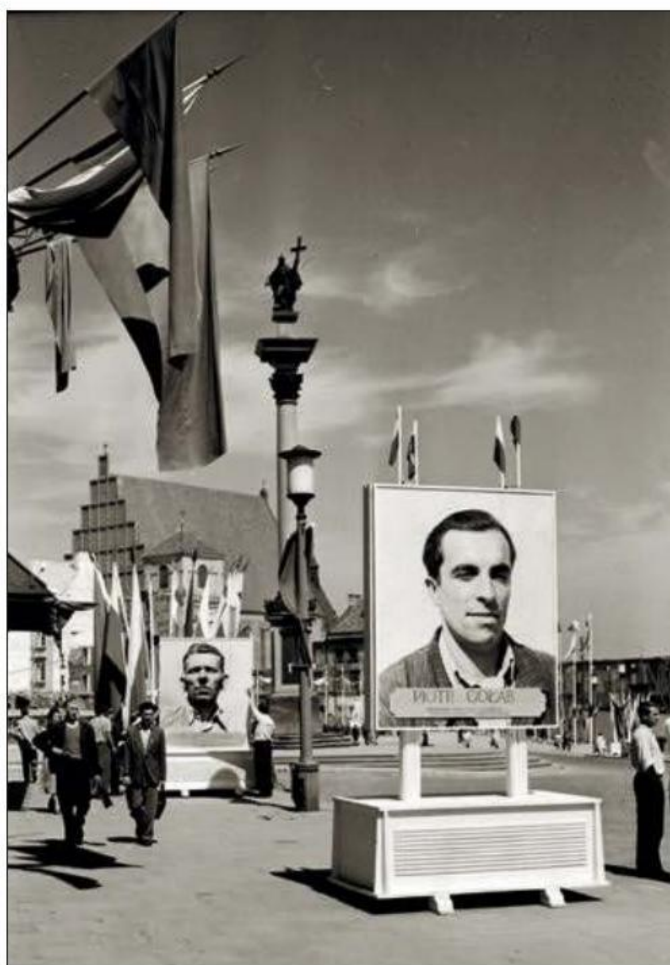
Portrety przodowników pracy, którzy wyróżnili się przy odbudowie Starego Miasta w Warszawie (1953).
