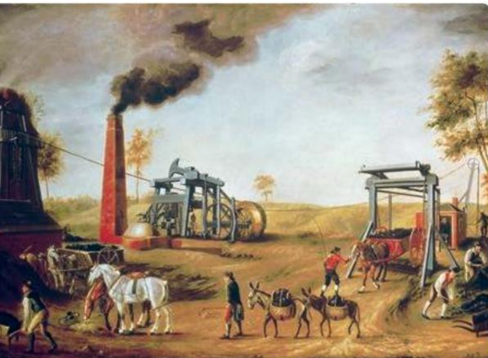
Maszyna parowa (na prawo od komina) napędza pompę, która osusza kopalnię – znacznie wydajniej, niż robiły to pompy napędzane przez konie. Obraz z XIX w.
