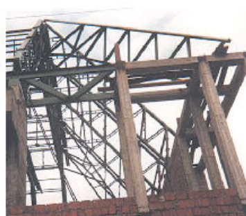
Szkielet dachu budynku
